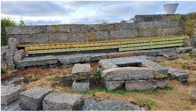
Skyttevallen har fått bänk och grillplats
